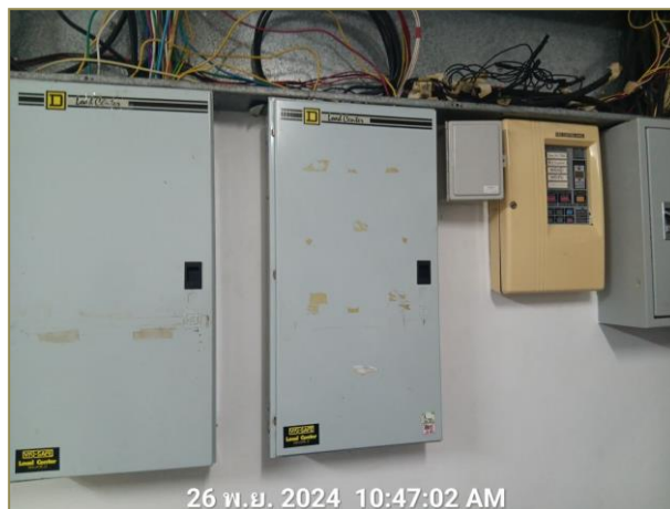
รูปที่ 2.18 ตู้ควบคุม FPA
